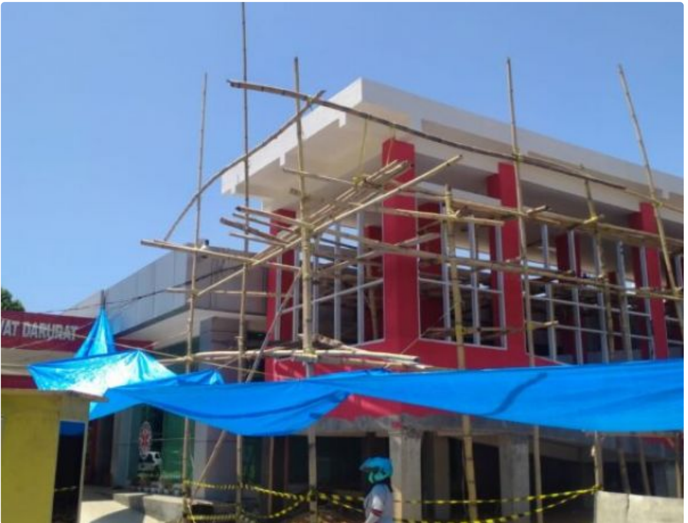
Kondisi bangunan ruang inap RS I laga Ligo sudah capai 65 persen
